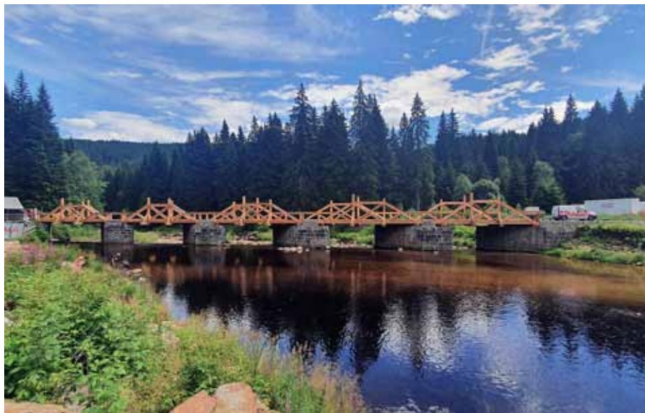
Most Rechle přes řeku Vydru – rekonstrukce
