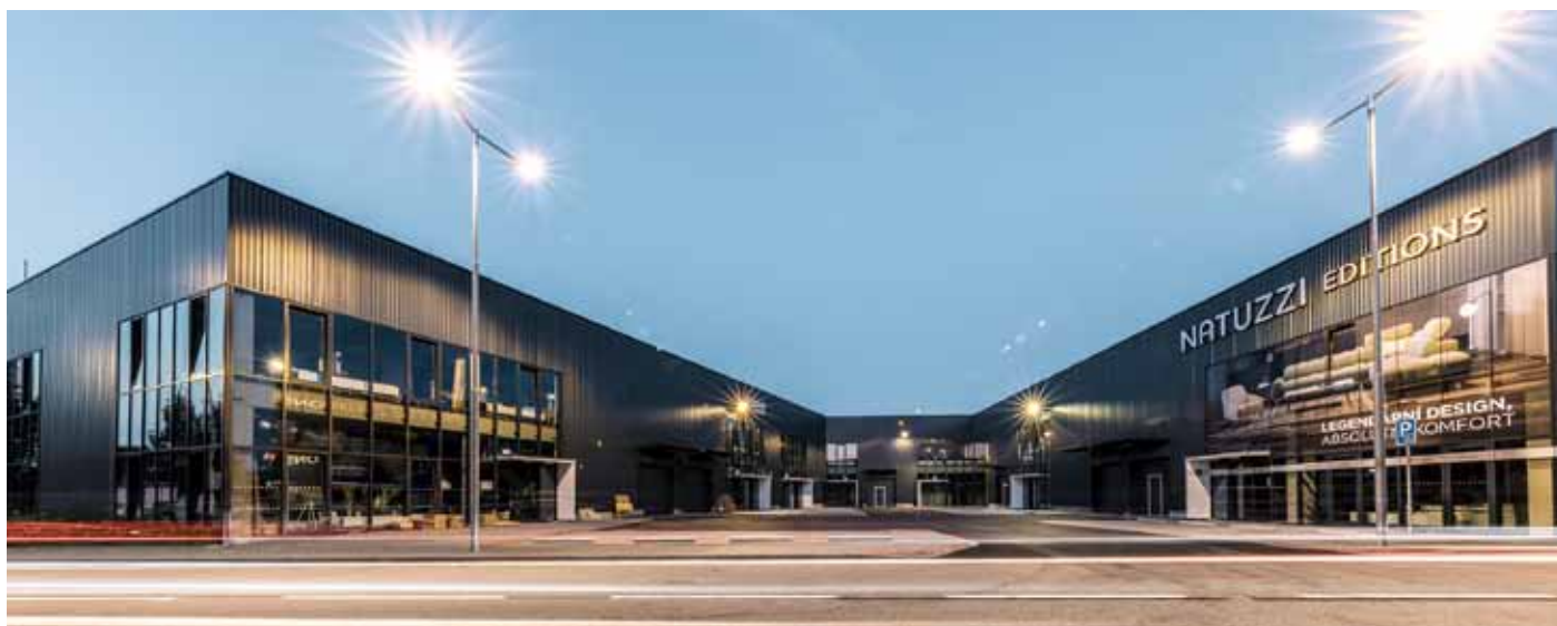
H-Park 2, výstavba business centra, část 2B, Brno
