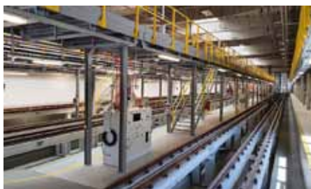
Zkušebna a rozšíření kolejíště průmyslové dráhy ŠKODA TRANSPORTATION
