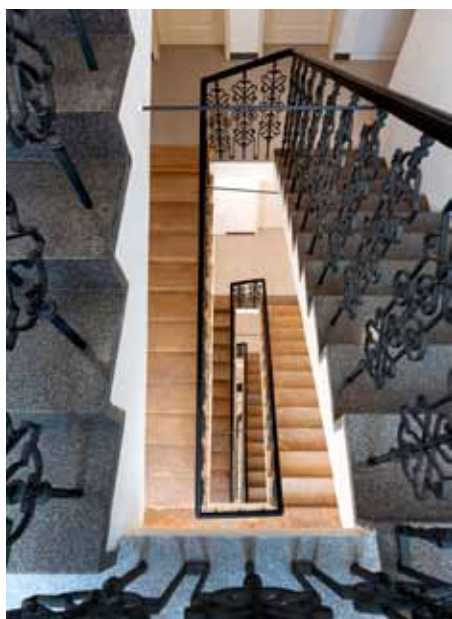
Rekonstrukce domu v Seifertově ulici, Praha 3
